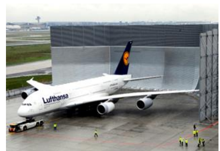
Standlaufeinrichtung Flughafen Frankfurt (M.)
